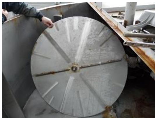
図 6 攪拌翼を外した様子
