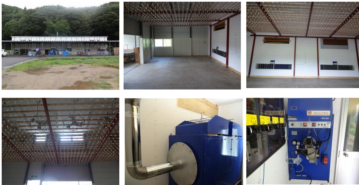
写真1 共同利用のコンブ乾燥施設（外観、乾燥室内部、間熱式乾燥機）
