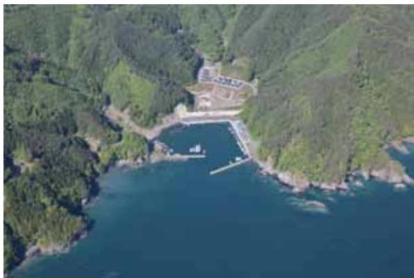
桑ノ浜漁港（釜石市）
