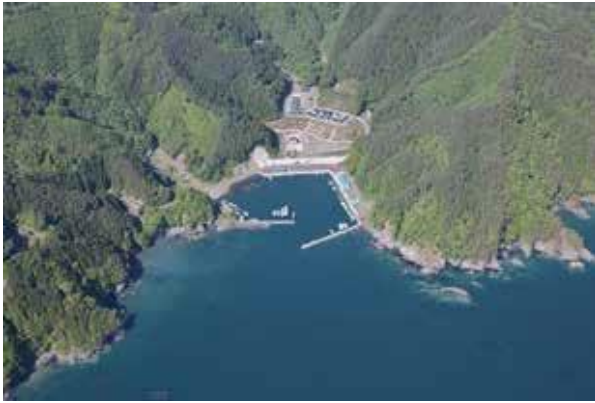
桑ノ浜漁港（釜石市）
