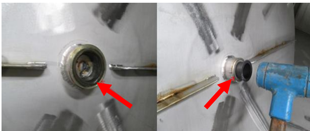
写真 34 ブッシュの状況確認 (左) および交換 (右)
