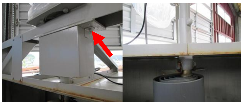
写真31 カバーの取り外しとジョイントの確認
