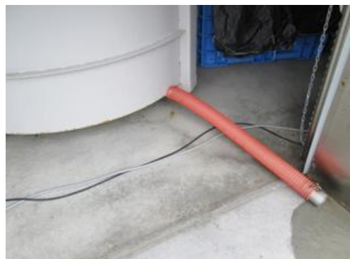
写真 36 真水の完全な排水の実施
