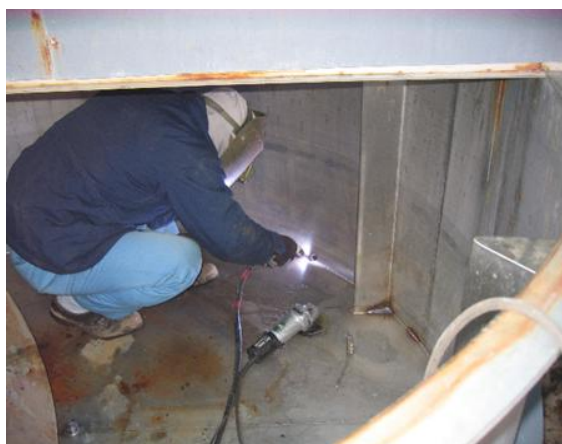
写真 29 ステンレスの穴の修理事例
