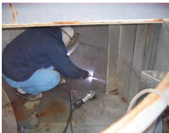
写真 29 ステンレスの穴の修理事例
