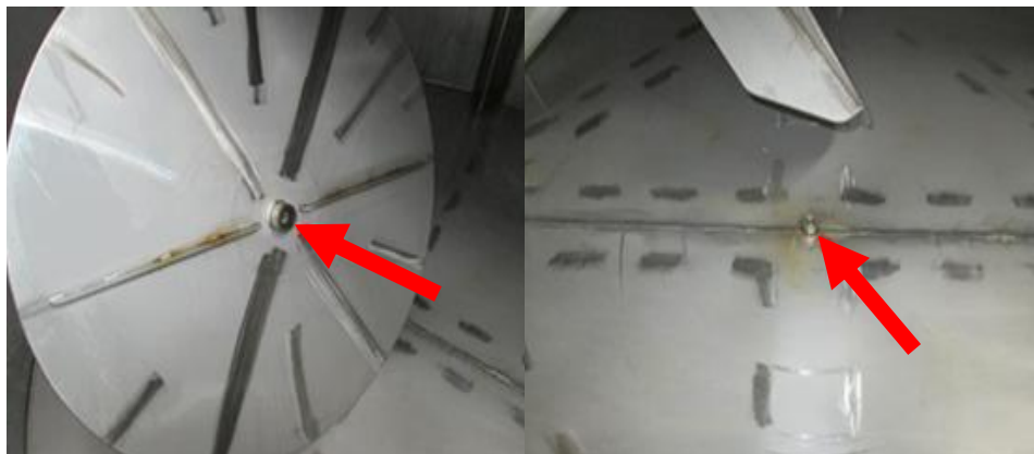
写真 33 攪拌翼の底面 (左) および振れ止め (右)
